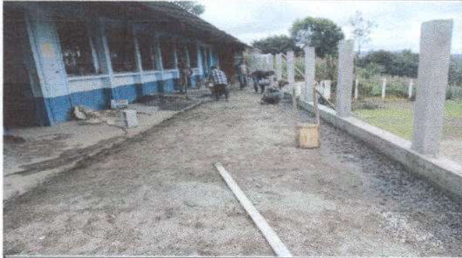
Foto1: Preparacion de area para fundicion de piso de torta de Concreto, frente cocina y Comedor.
