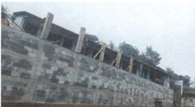
Foto3. Proceso de construccion del Muro Perimetral.
