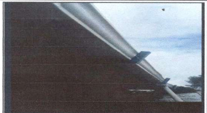
Foto 2: colocacion de canal de PVC, reparacion de bajada de agua pluvial tubo PVC 3"y sustitucion de Pescantes de metal para canal..
